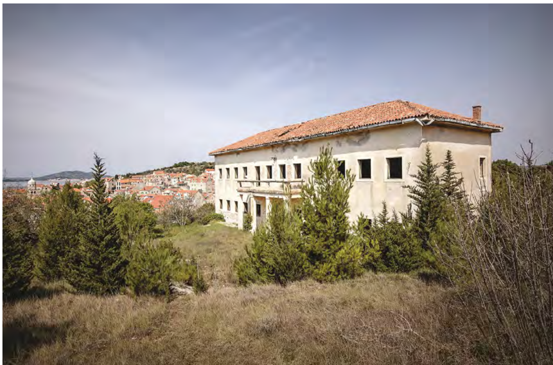
Slika 91 – Zgrada stare škole u naselju Šepurine (Izvor: https://www.telegram.hr/ )
