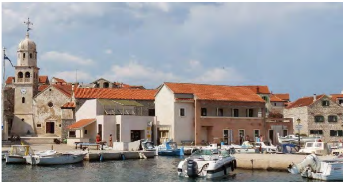
Slika 98 – Postojeća zgrada u naselju Šepurine (Izvor: Projektni zadatak, mr.sc. Tomislav Krajina, dipl.ing.arh.)
