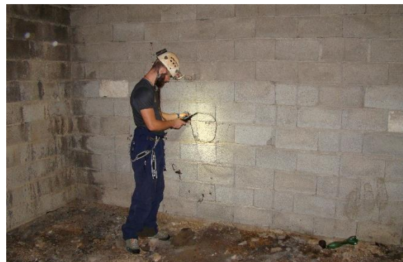
Slika 29. Kuća, Dragišići, pregled pukotina (Foto: G. Rnjak)
