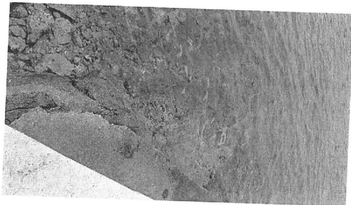
slika 10. Odnešen postojeći nasip i obala ispred šetnice.
